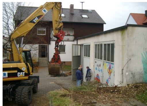
Nov. 2003 - der Umbau beginnt
