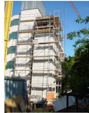
Mai 2004 - 2. Aufzug im Bau
