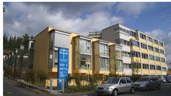
Neubau Schwaigerstraße und neue Fassade Hellstraße
