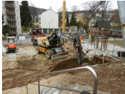
endlich kann der Bagger arbeiten
