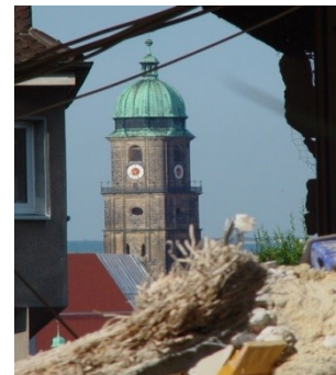
Nach dem Abriss der alten Pflegestation ist der Blick frei auf St. Martin
