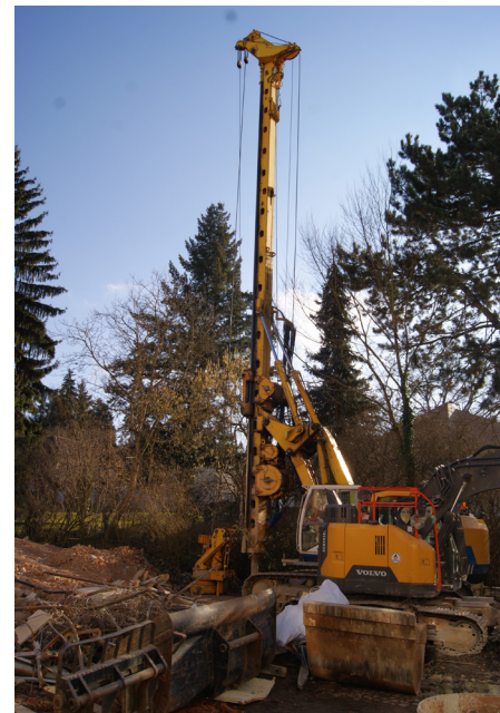
Setzen der Bohrpfehlwand
