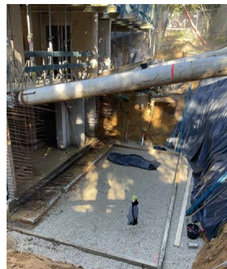
Verschallung für die Bodenplatte vom Keller
