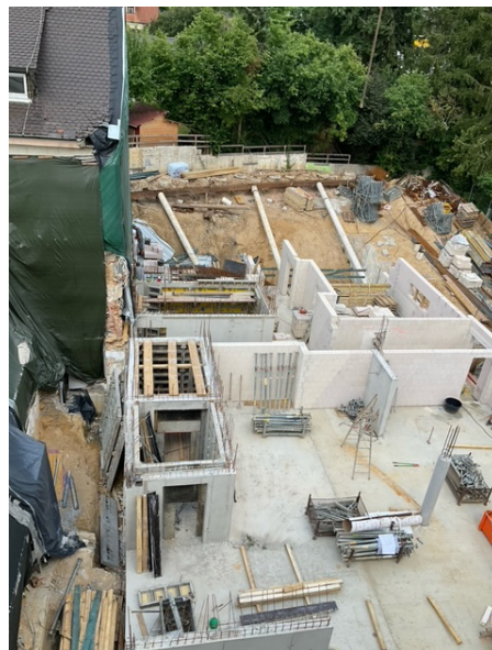
Errichten des Erdgeschosses
